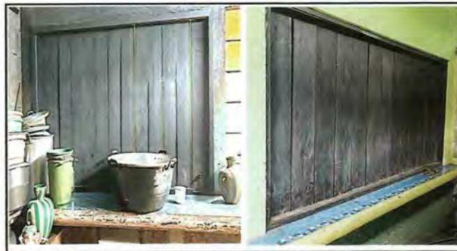
Foto 4: Sustitucion de ventanas por Ventanas PVC para mejorar la ventilacion e iluminacion de Cocina + Instalacion de piso ceramico
